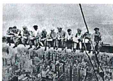
Fotografia de: Charles C. Ebbets Operários a almoçar nas alturas durante a construção do edifício RCA no Rockefeller Center (EUA, 1932)
